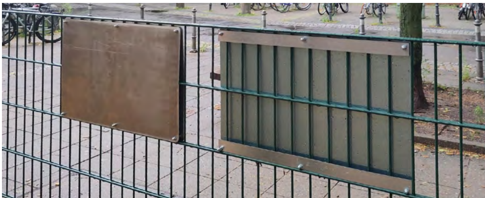
Konterplatte / Rückseite des Aluminumschildes © KoSP / BA Mitte
